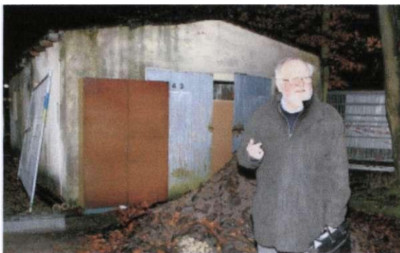
Unansehnlich: Die Hütteneben der Dokumentationsstätte ist stark sanierungsbedürftig, wie Manfred Büngeener erklärt.
